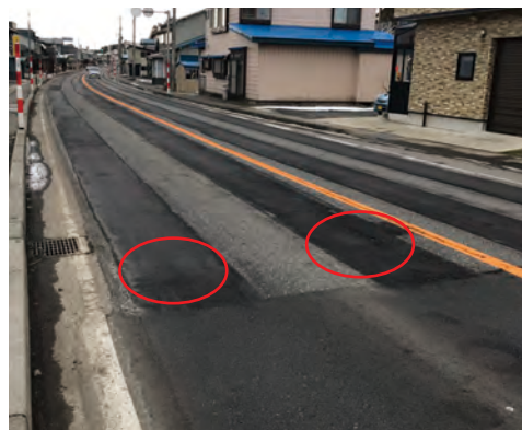
道路の改修箇所
